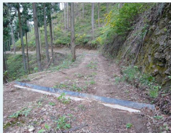
写真2 ゴム製の簡易横断排水施設
