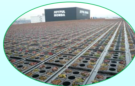
セダム単一の屋上緑化
