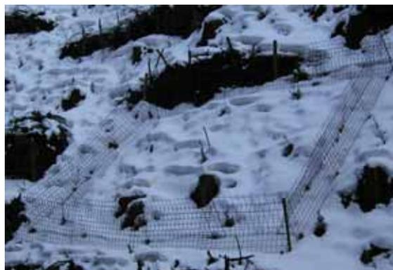
図-3 「金網グレーチング」の現地設置の状態
