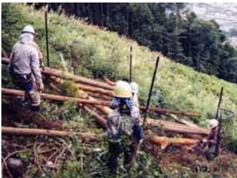
図 - 4 「丸太グレーチング」の設置風景
