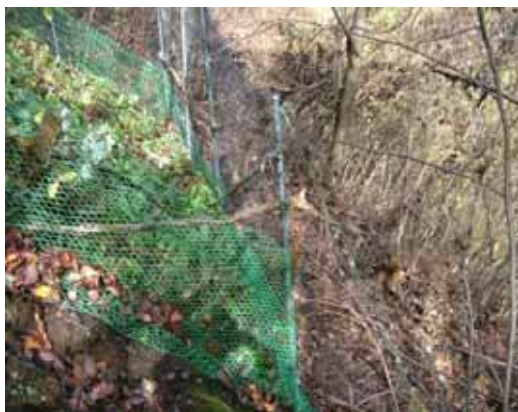
写真 - 1 コドラート の侵入防止柵の状況
