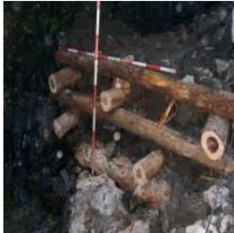
写真 4 渓流床固工の丸太組
