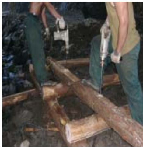
写真 2 接続部の施工
