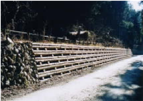
写真 - 1 ウッドブロック現況(盆堀林道)
