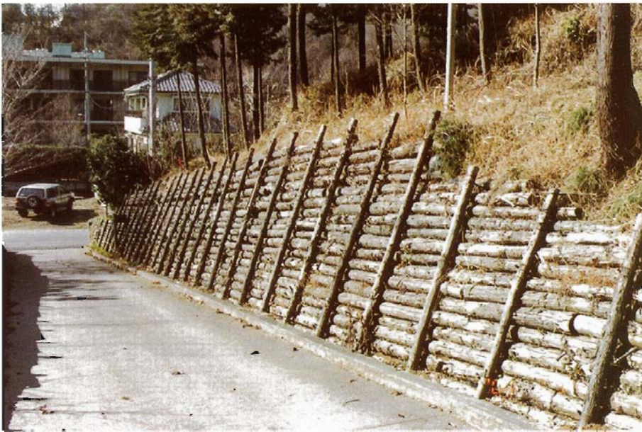
写真-1 法面Cの状況
