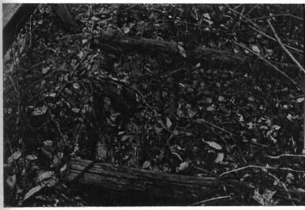
写真-1 スギ間伐材による法面保護工 (1994年 あきる野市戸倉地内)
