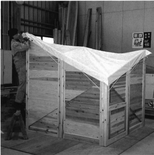
写-1 簡易組立ハウスの試作品
