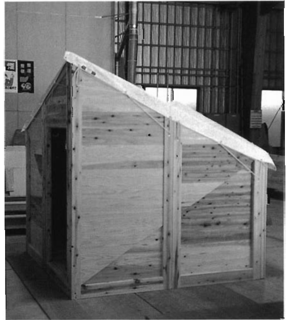
写-1 簡易組立ハウスの試作品
