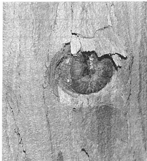
写真-2 巻き込んだ状態
