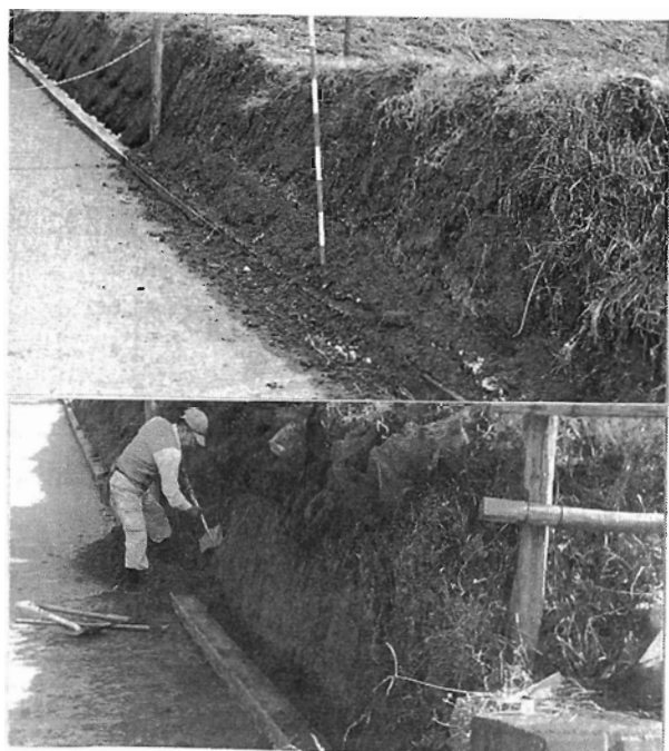
写真-1 施工前・不整法面の整形
