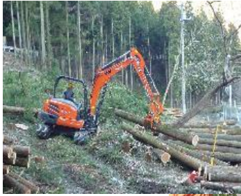
重機による伐採木整理
