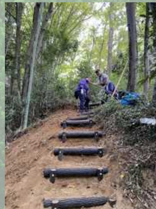
林内の歩道整備 (日野市)
