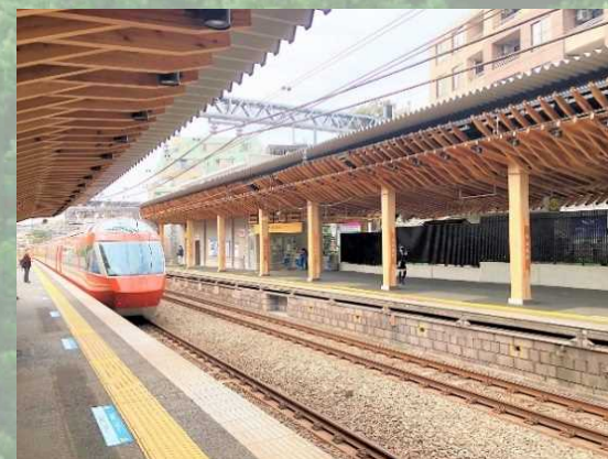
小田急小田原線 参宮橋駅(渋谷区) 令和2年 11月竣工
