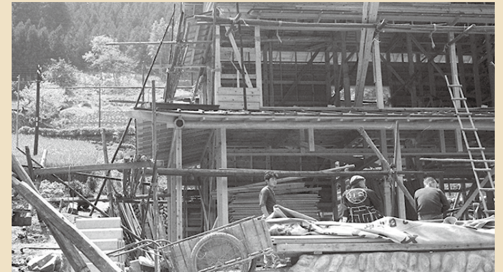
建築中の住宅
