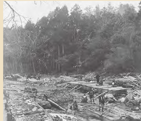
戸倉村での筏の組立作業
