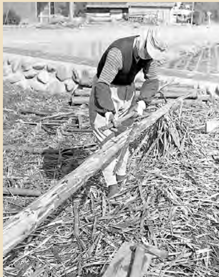
スギの皮を剥いで足場丸太を生産(昭和44年頃)
