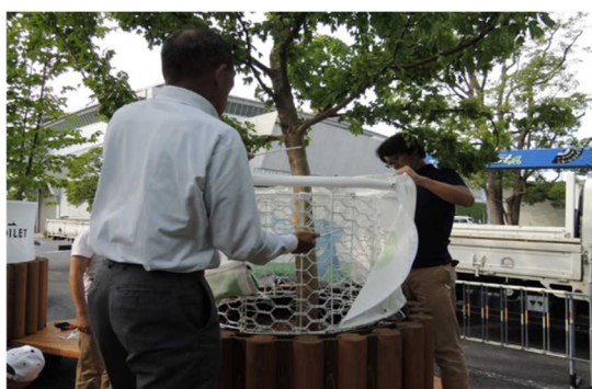
①スクリーン用金網上部にノズル取付
