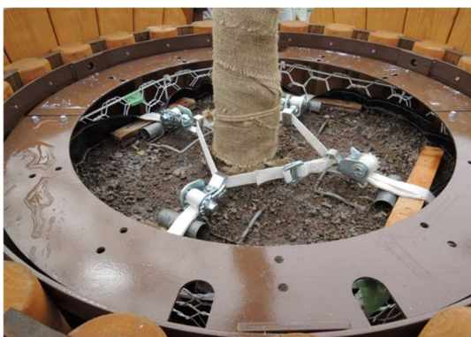
⑲スクリーンを乗せる枠蓋の固定
