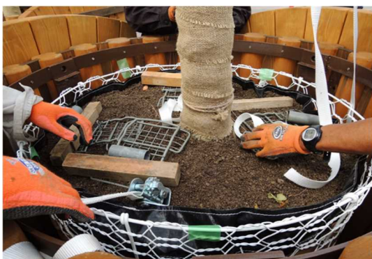
⑰地下支柱による根鉢の固定
