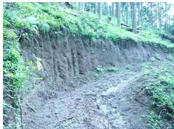
写真－10 高さ2mを超えた切土が連続した事例
