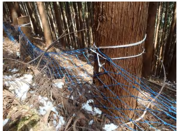
写真-34 工事範囲外への落石防止用ネット
