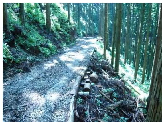
写真-1 急傾斜地での作業道作設事例 路面の砂利敷、丸太組が施工されている
