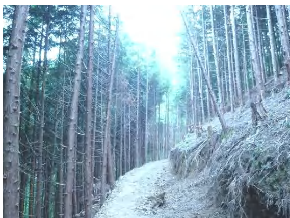
写真-30 切土法面の崩落 山側の残存木は、根が揺すられると危険
