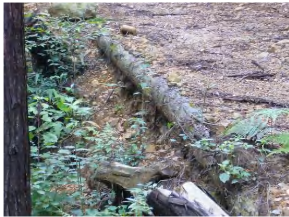
写真-16 丸太による路肩補強
