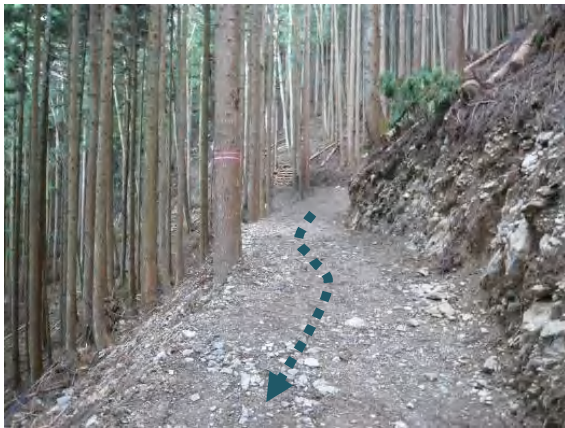
写真－５ 波形の縦断勾配による分散排水
