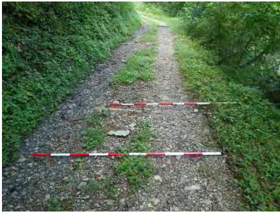
写真-15 路面全体をカバーする横木の設置例 (ポールの位置まで控え丸太が入っている)
