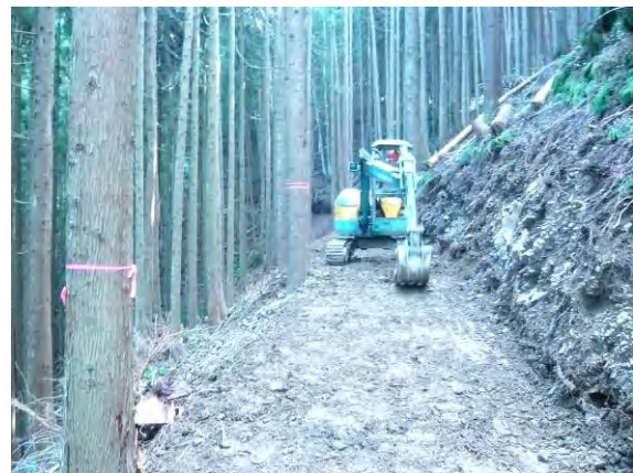
写真－8 支障木の伐倒は必要最低限にとどめる（テープを巻いた木は残す）
