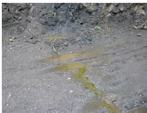
排水状態の悪い箇所は、降雨後に見回りを行うと発見しやすい。 左(写真-23)は縦断勾配の緩い箇所 右(写真-24)は切土面からの湧水発生箇所
