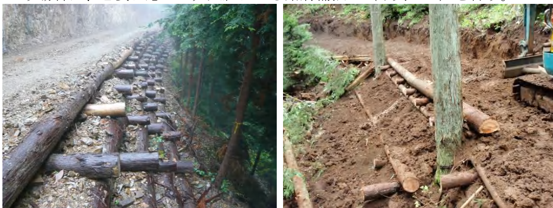
写真－13、14 丸太組施工例
