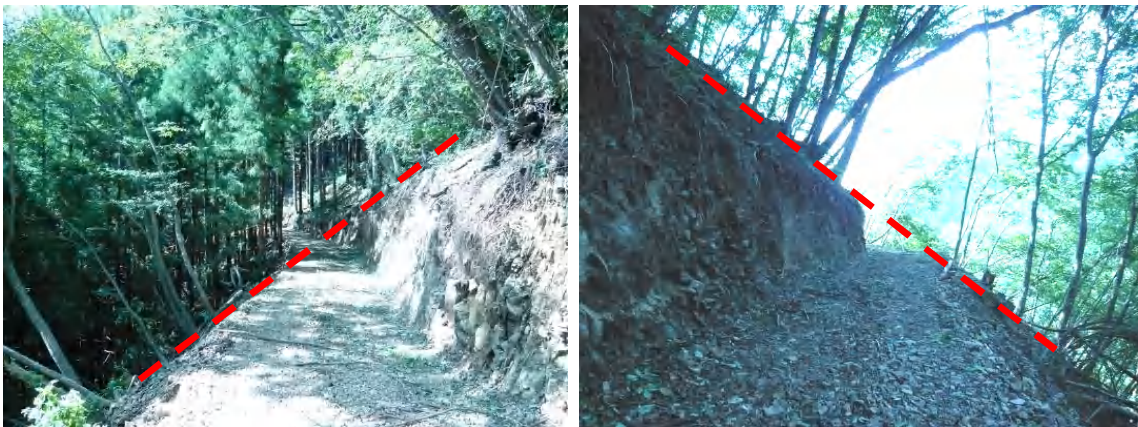
写真-11、12 切土のみ施工の例（発生土は原則路線内で処理する）
