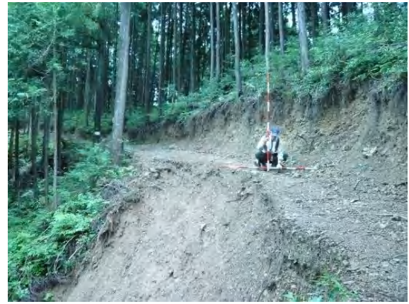
写真-32 降雨後に、被害規模が拡大
