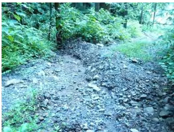
写真-21 盛土による水処理
