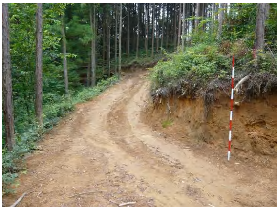
写真－9 切土高は1.5m程度を上限に施工することが望ましい
