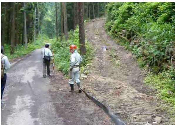
写真-33 林道との境に設置した水切り
