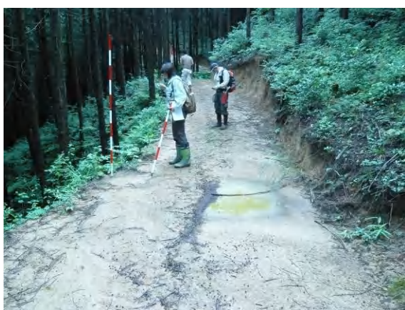
排水状態の悪い箇所は、降雨後に見回りを行うと発見しやすい。 左(写真-23)は縦断勾配の緩い箇所 右(写真-24)は切土面からの湧水発生箇所
