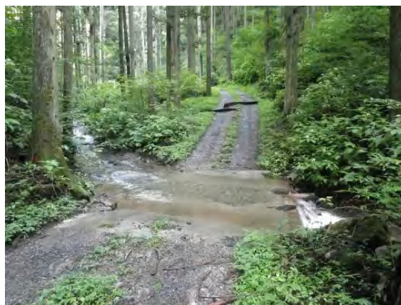
写真-22 洗い越し施工例
