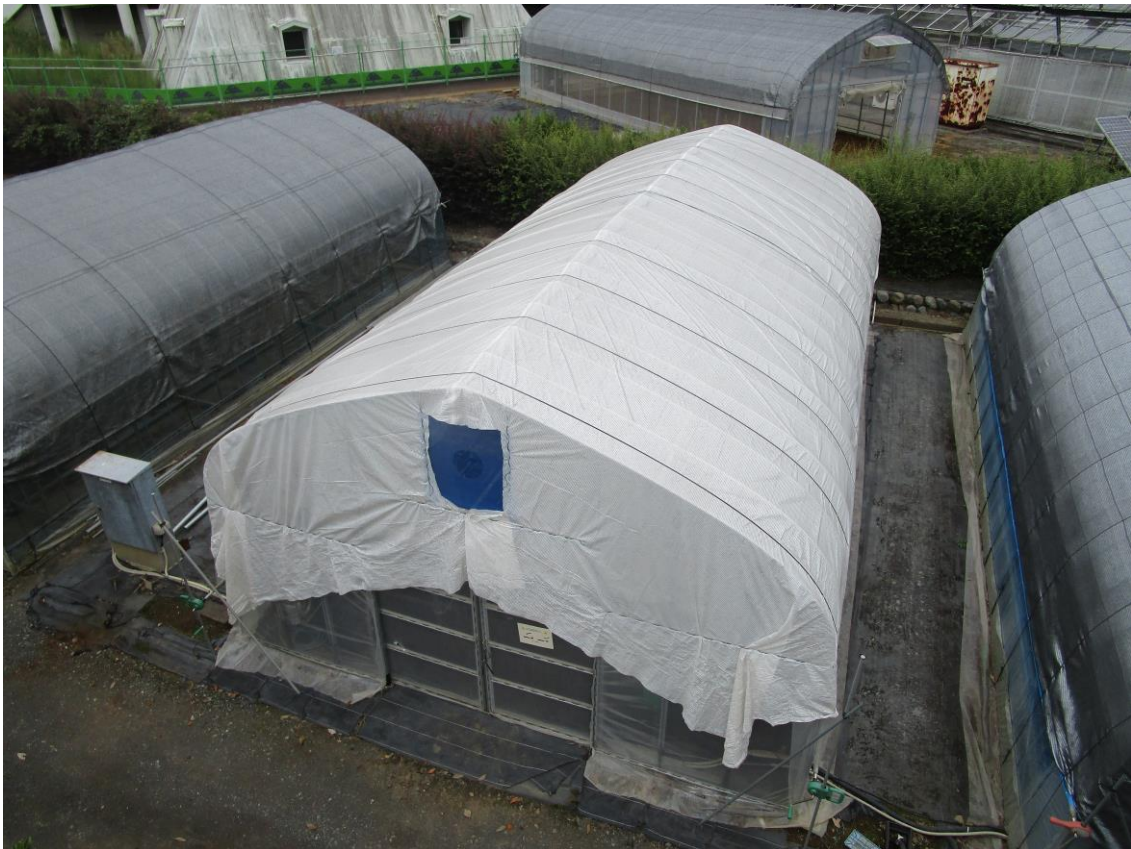
写真4 ダイオカルクール SW-70 外張りの様子
